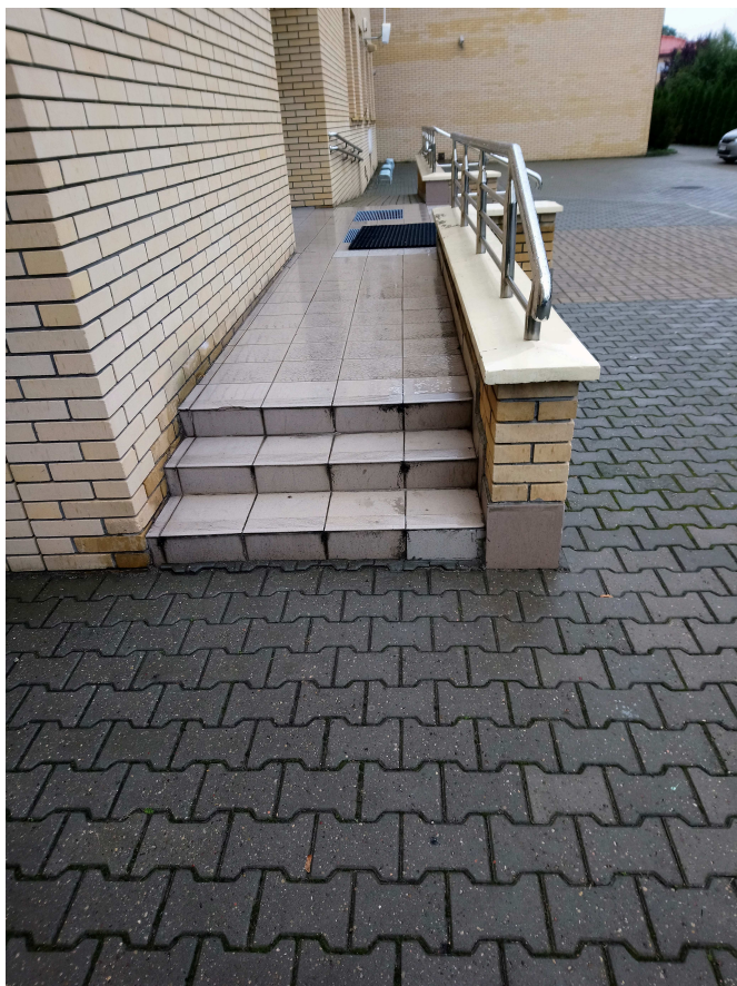
Fot. 4 Stan istniejący schodów wejściowych
